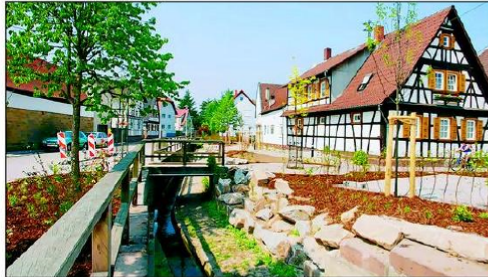
Westheim ist ein Referenzobjekt des an ILE beteiligten Planungsbüros. Das Foto zeigt Dorfplatz und Wiesenweg nach der Dorferneuerung 2004.
