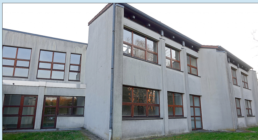
Das Gebäude der ehemaligen Bienwaldschule
