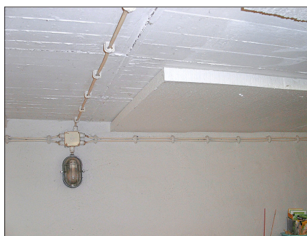
Dämmung der Kellerdecke.
