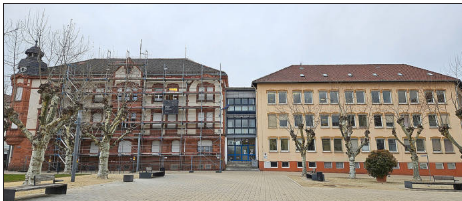
Das historische Festungsgebäude (links) soll saniert, der marode rechte Gebäudeteil abgerissen und neu errichtet werden. Foto: KV GER/sey
