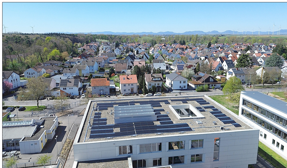
Photovoltaik auf dem Dach der IGS Rülzheim..
