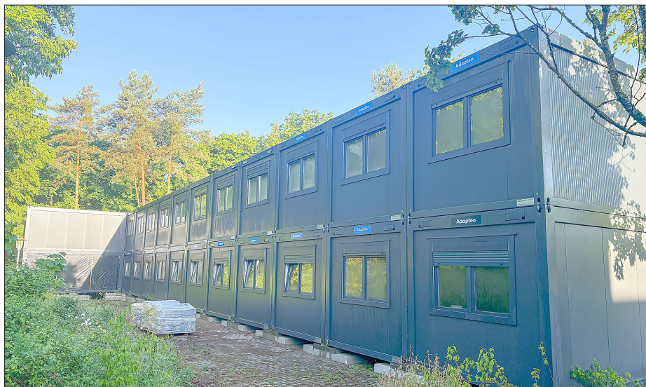
Die Schulcontainer sind aufgebaut. Sie werden bald mit bunter Folie beklebt. Foto: KV GER/aj
