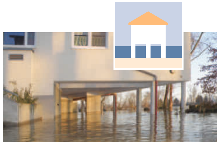
Ausweichen: zum Beispiel durch Aufständern von Gebäuden
