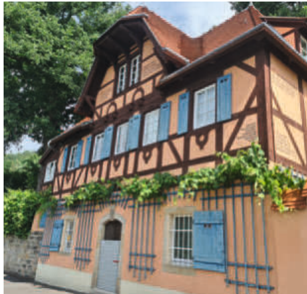
Denkmalschutz mit Hochwasserschutz
