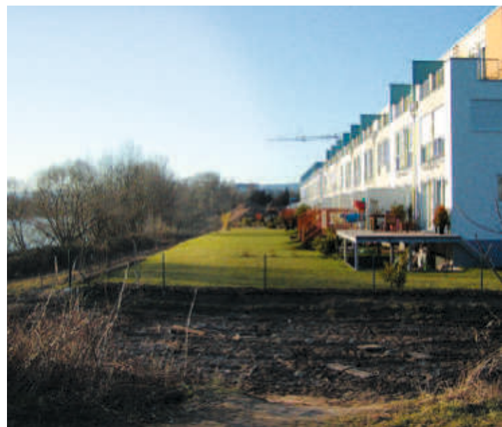
Hochwasserangepasste Bauweise mit erhöhtem Erdgeschoss
