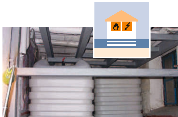
Anpassen: zum Beispiel durch Sicherung bestehender Tankanlagen
