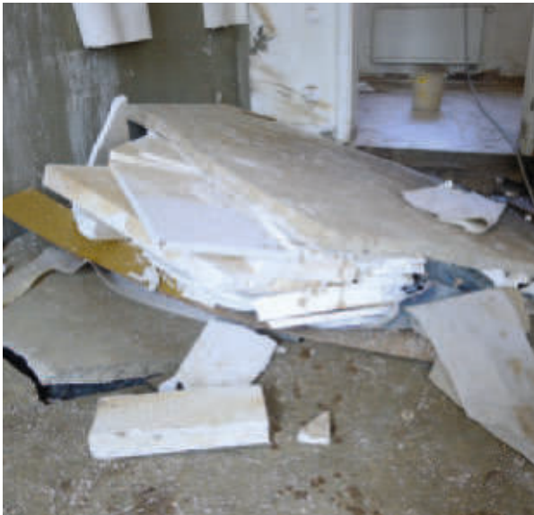
Aufgeschwommene Fußbodenkonstruktion
