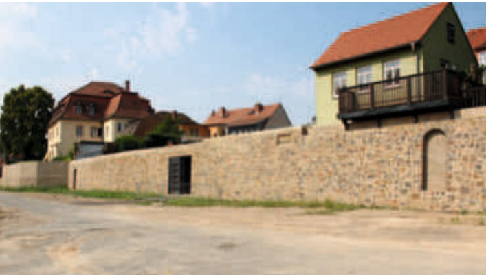
Integrierter Hochwasserschutz in der historischen Stadtmauer ...
