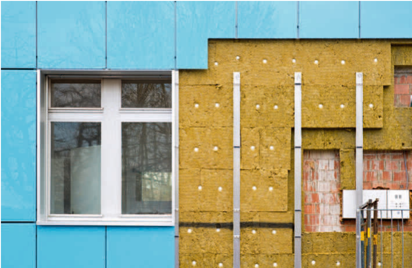
Hinterlüftete Fassadenkonstruktion
