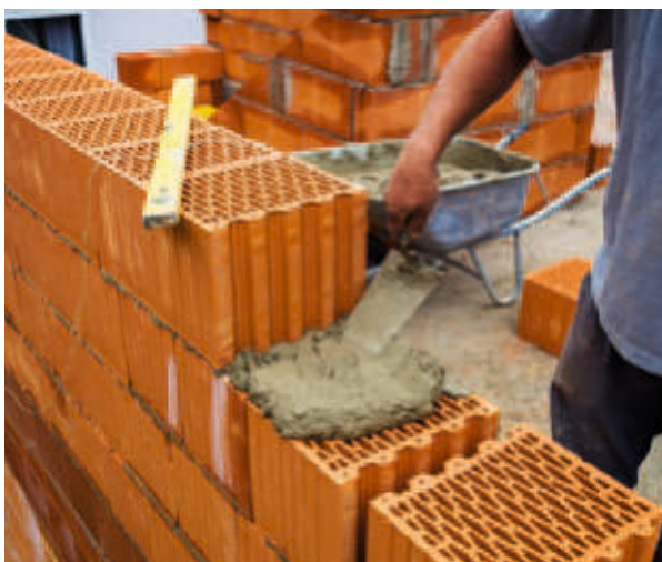
Mauerwerk aus Hochlochziegel
