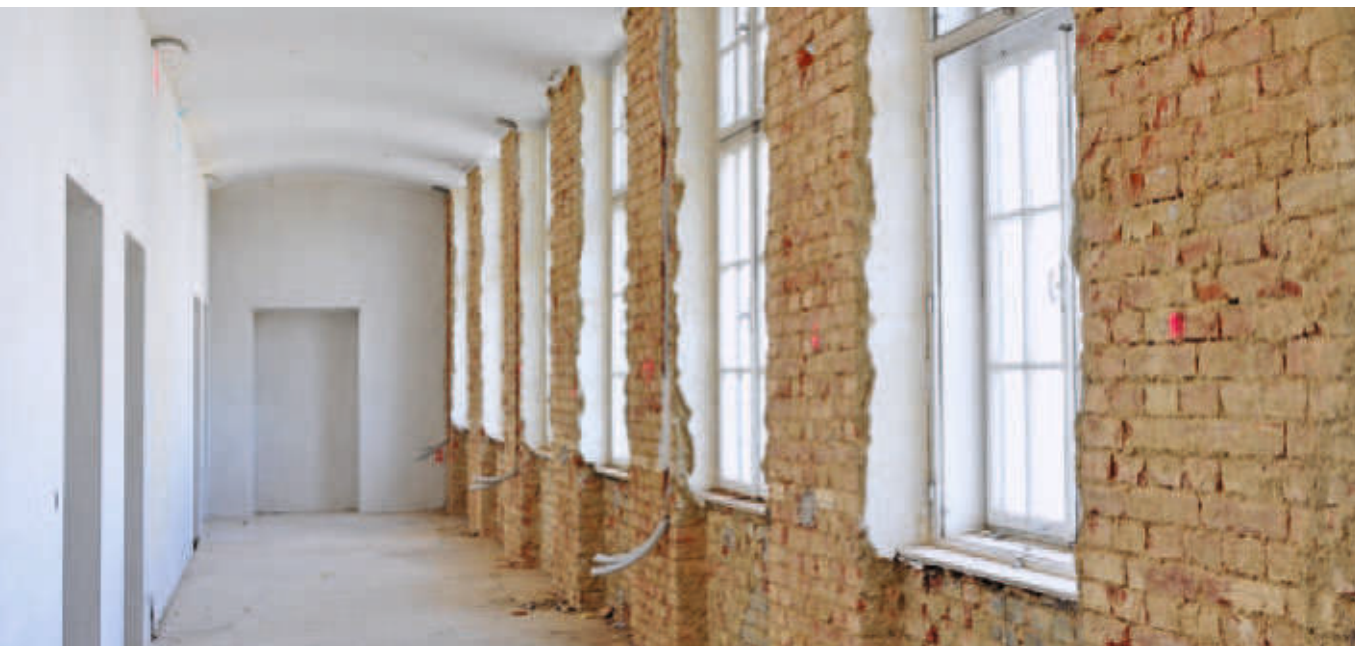
Entfernter Putz zur besseren Trocknung einer Außenwand
