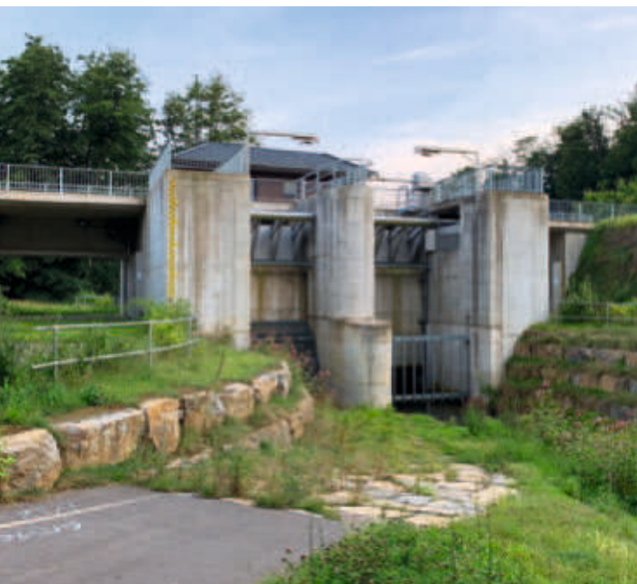
Verschlussbauwerk eines Hochwasserrückhaltebeckens
