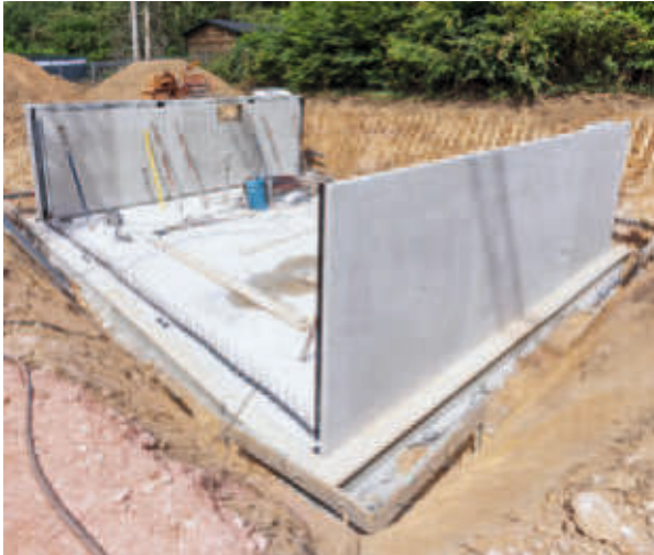
Keller in WU-Bauweise
