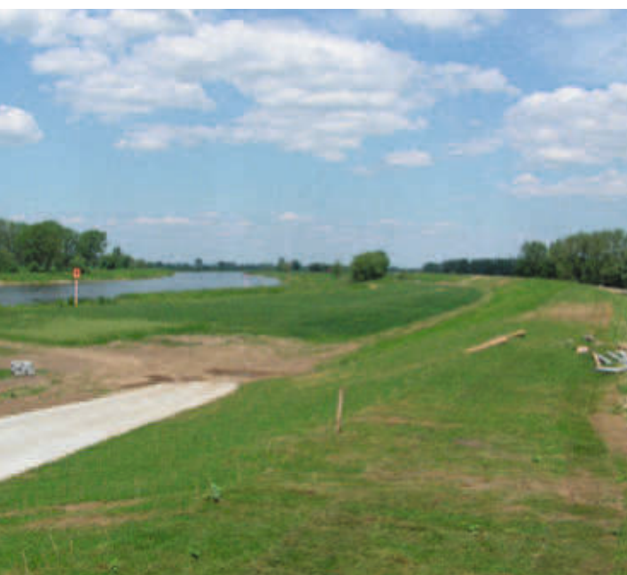
Saniertes Hochwasserschutzdeich an der Elbe
