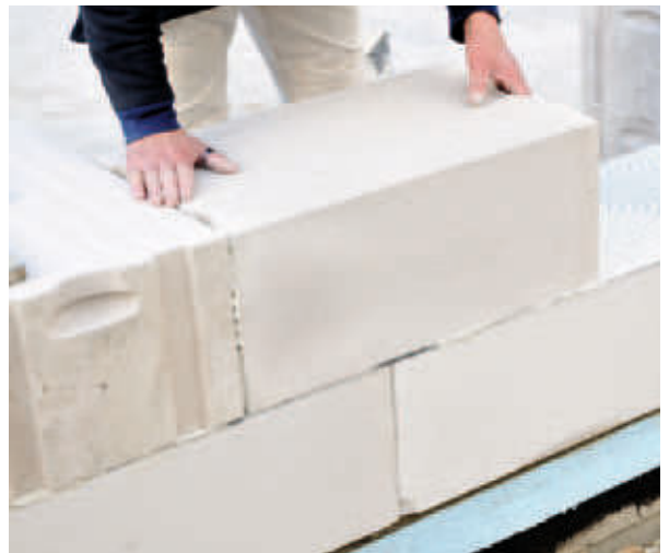
Mauerwerk aus Porenbeton-Plansteinen
