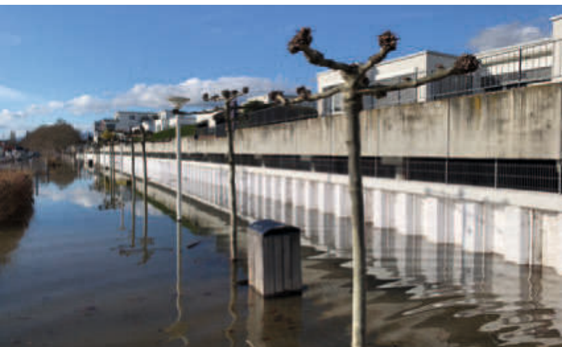
Hochwasserschutzwand mit eingemrammter Stahlpundwand
