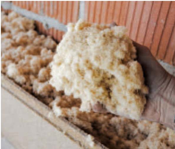
Holzweichfasern für die formatvariable Wärmedämmung von Hohlräumen
