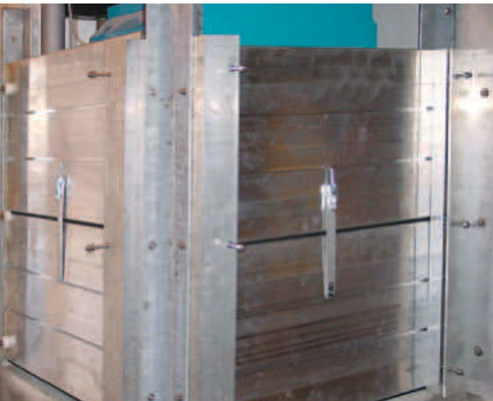
Sicherung einer Feuerstätte vor dem Wasserzutritt
