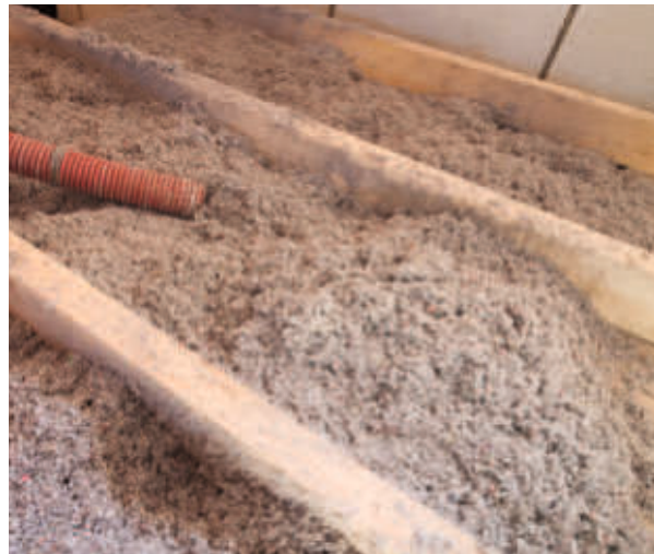
Anwendung von Zelluloseflocken im Fußbodenbereich
