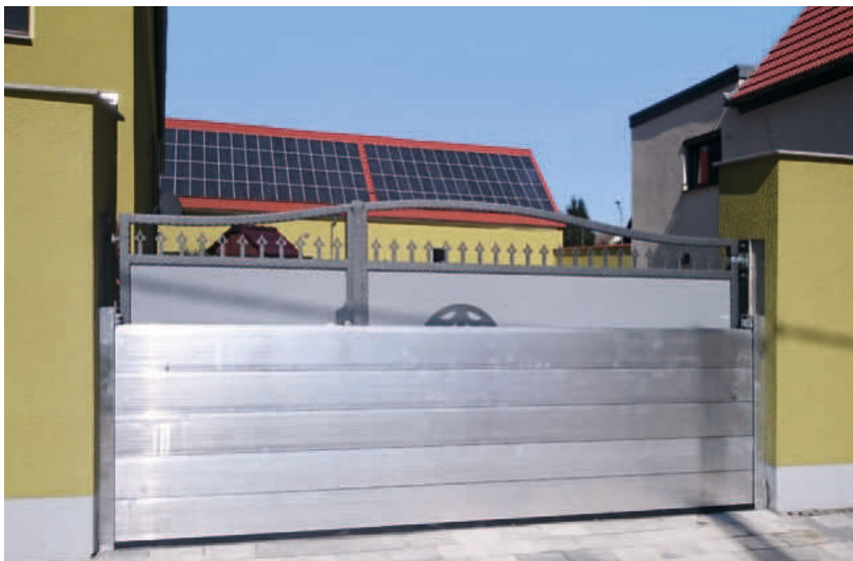
Mobiler Hochwasserschutz mit Dammbalken
