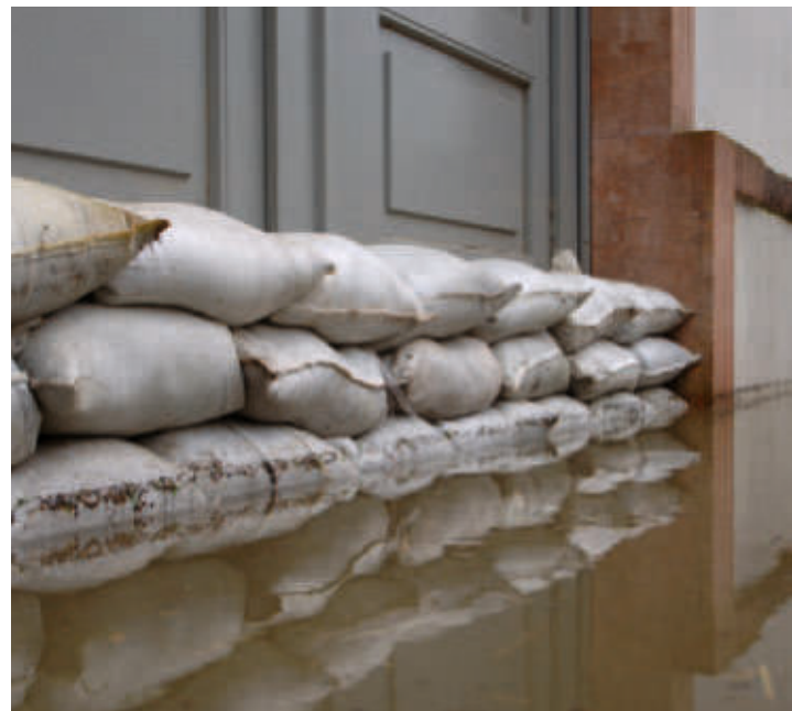
Notfallmäßiger Objektschutz mit Sandsäcken
