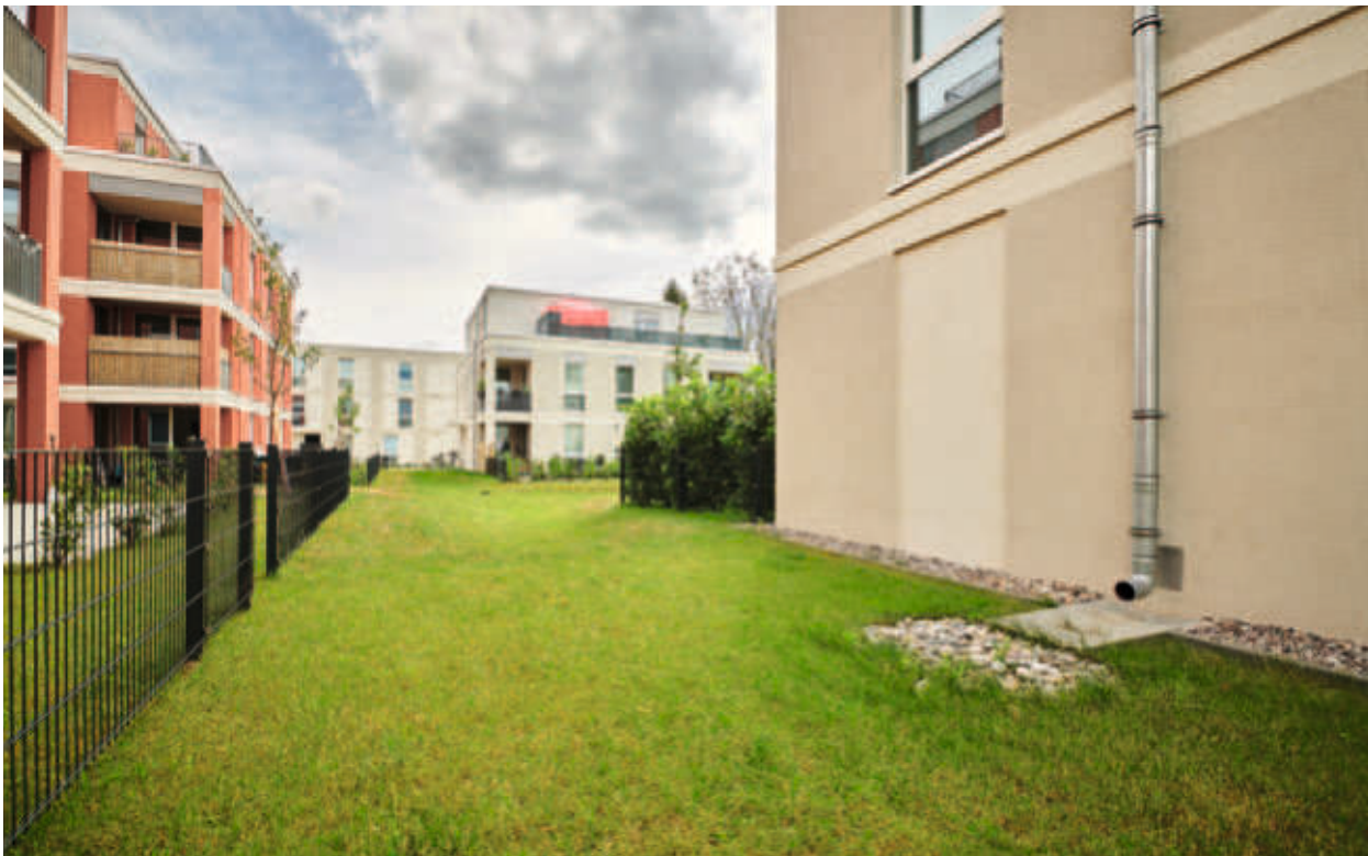
Dezentrale Rückhaltung von Niederschlagswasser
