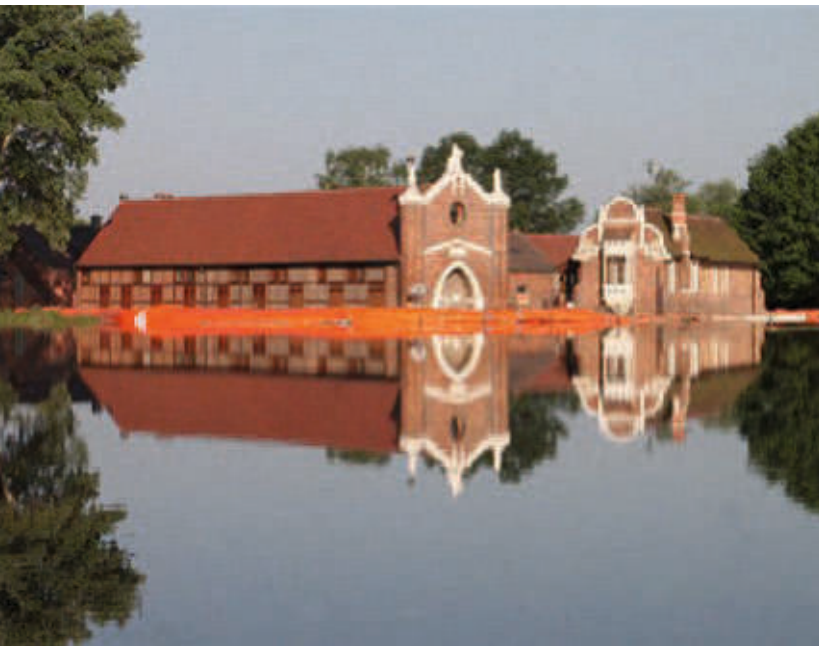
Objektschutz mit mobilem wassergefülltem Schlauchsystem
