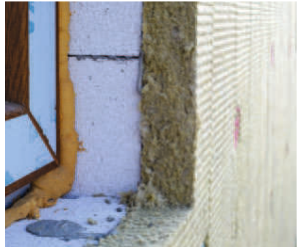
Einsatz von Mineralfaserplatten als Außenwanddämmung
