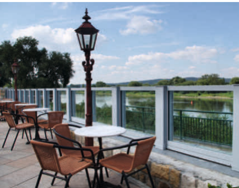
Hochwasserschutzwand mit Sicherheitsglas
