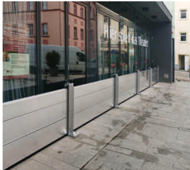
Objektschutz mit teilmobilen Schutzelementen
