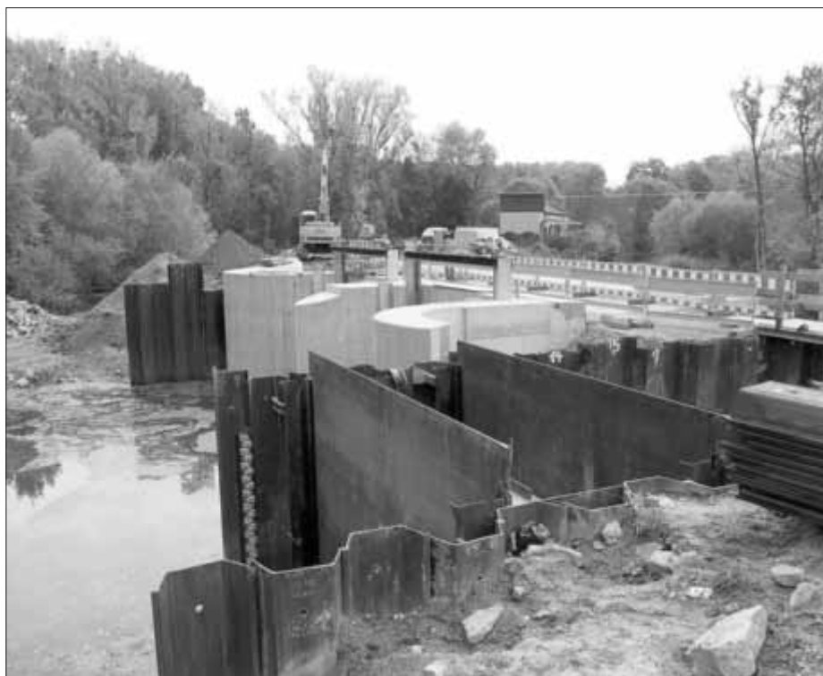
Erster Baustein für einen wirkungsvollen Hochwasserschutz: Die im Bau befindliche SchlieÙe am Michelsbach bei Sondernheim.
