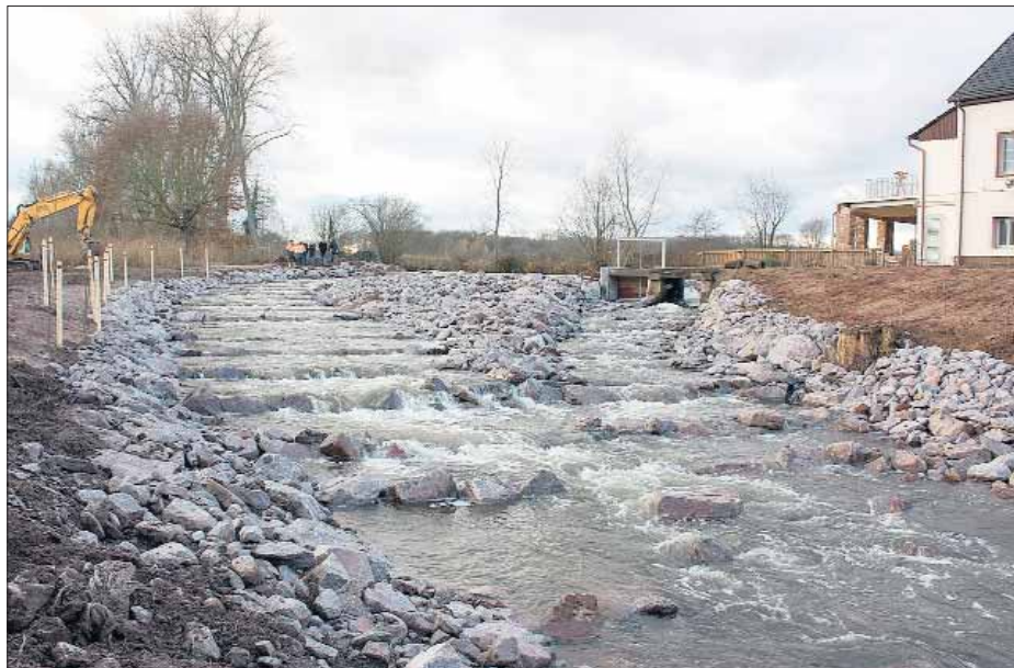
Die neu entstandene Fischrampe an der Zeiskamer Mühle.
